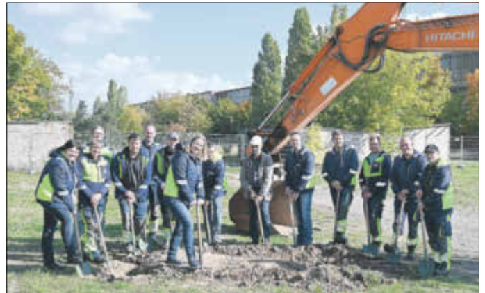
Spatenstich für das neue Bauhof-Gebäude
