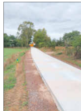
Blick nach Neuderben - Der Ausbau des Seitenstreifens (Bankett) erfolgt noch
