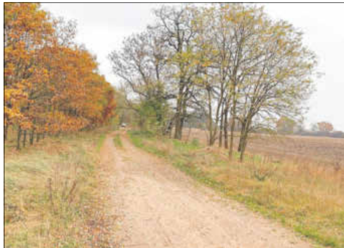
Weg vor dem Ausbau (Blick Richtung Seedorf)
