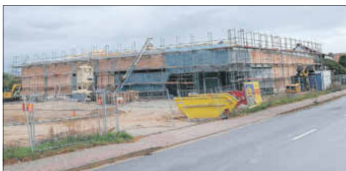
Stand der Bauarbeiten 03.10.2022
