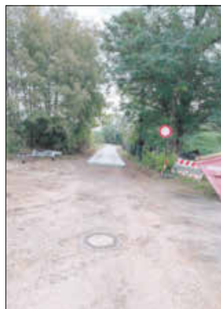
Beginn des Radweges ab Neuderben - Der Anschluss an die L54 erfolgt in Asphaltbauweise
