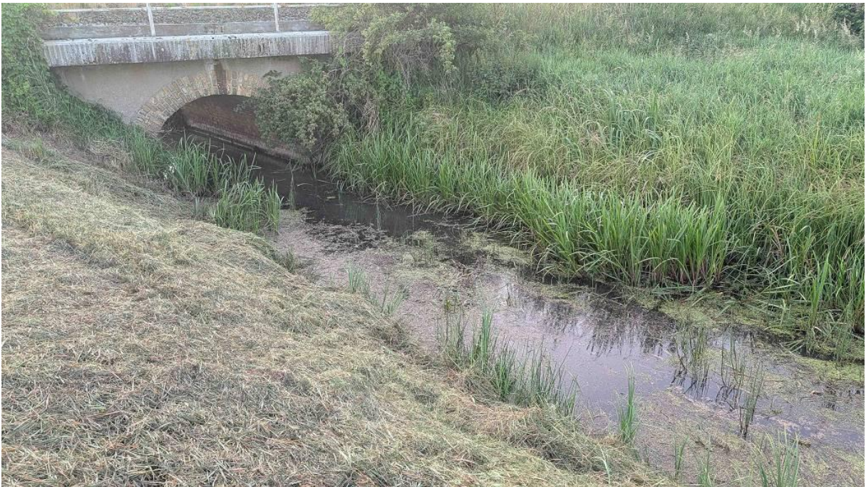
Abbildung 13 Lehmkuhlengraben im Bereich der alten Bahnbrücke am 18.06.2025 (Foto 6)
