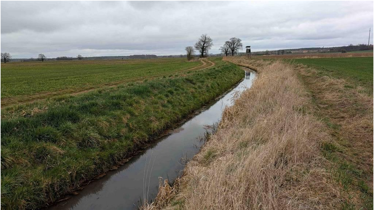
Abbildung 4 Roter Brückengraben wasserführend am 26.03.2025 (Foto 1)
