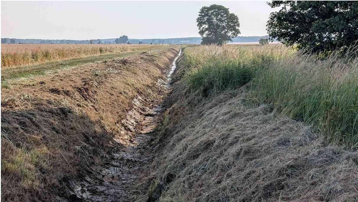
Abbildung 11 Roter Brückengraben im Westen des UG ausgetrocknet am 18.06.2025 (Foto 8)
