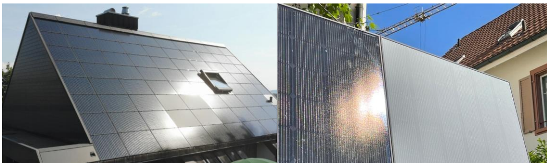
Abbildung 9: links: Module mit satinierter Folie [3], rechts: nachträglich sandgestrahltes Modul [4]
