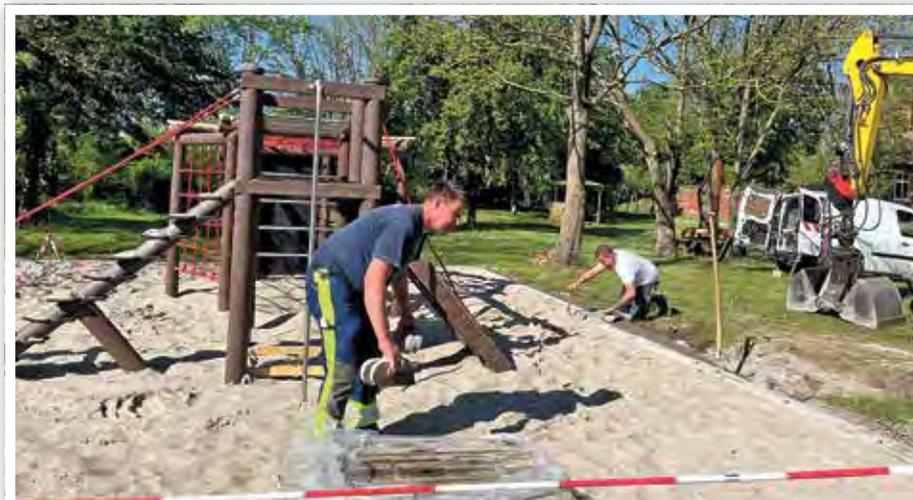
Zum Schluss wurden einige Tonnen Sand als Fallschutz eingebracht und die Einfassung gesetzt.
