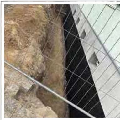
Aushub und Trockenlegung am Dorfgemeinschaftshaus in Derben
