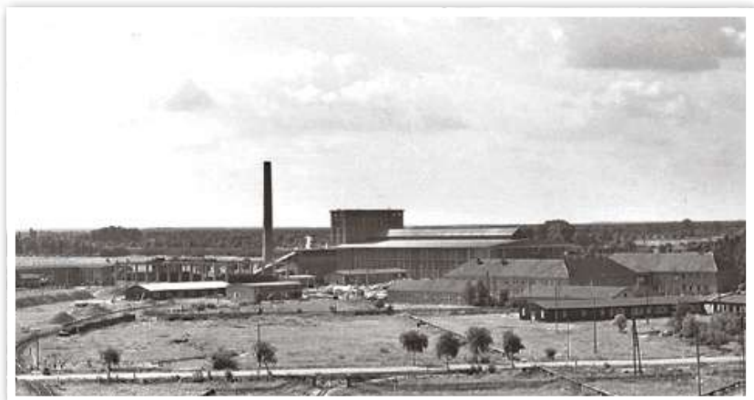
Eine historische Ansicht des Schwellenwerkes in Güsen.
